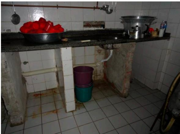
Necessidade de manutenção da estrutura de alvenaria, o que facilita o acúmulo de sujidades e abrigo de pragas.
