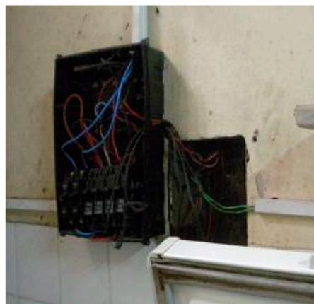
Botijão de gás em local inadequado, quadro de energia elétrica exposto → risco de acidentes.
