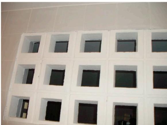
Ausência de telas milimétricas de proteção, necessárias para evitar o acesso de pragas.
