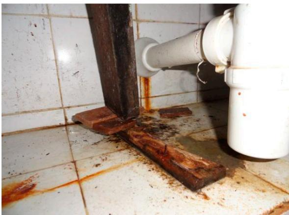
“Manutenção improvisada”. A fim de não inutilizar a pia foi improvisado apoio necessário à estrutura.
