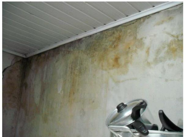
Infiltração nas paredes do estoque de alimentos e guarda de utensílios.
